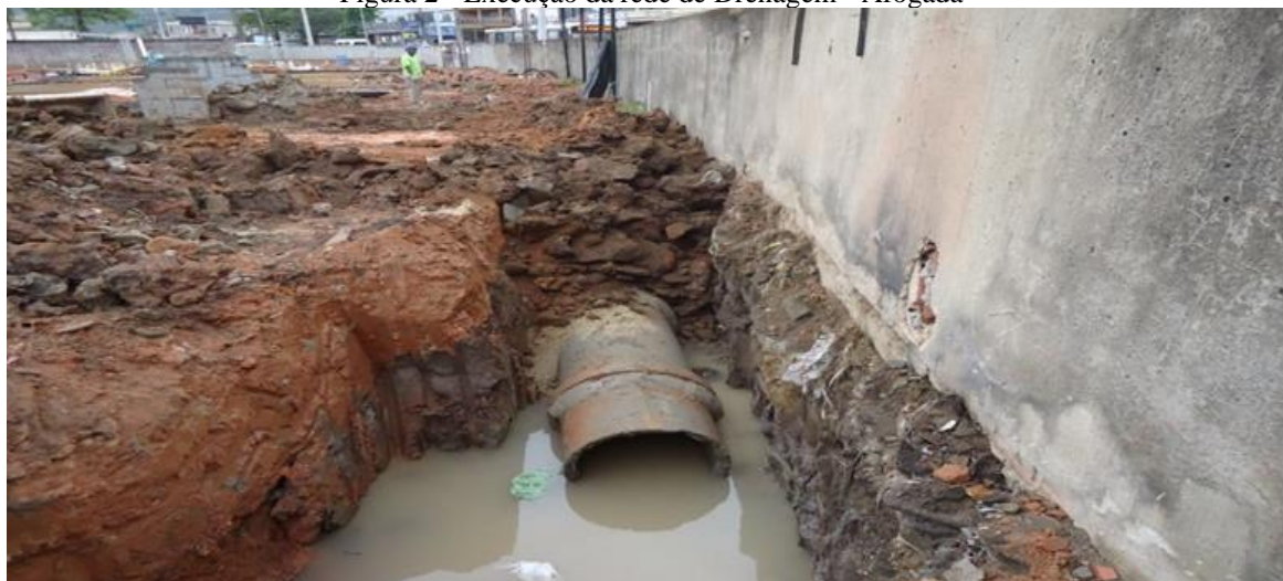
Figura 2 - Execução da rede de Drenagem - Afogada
