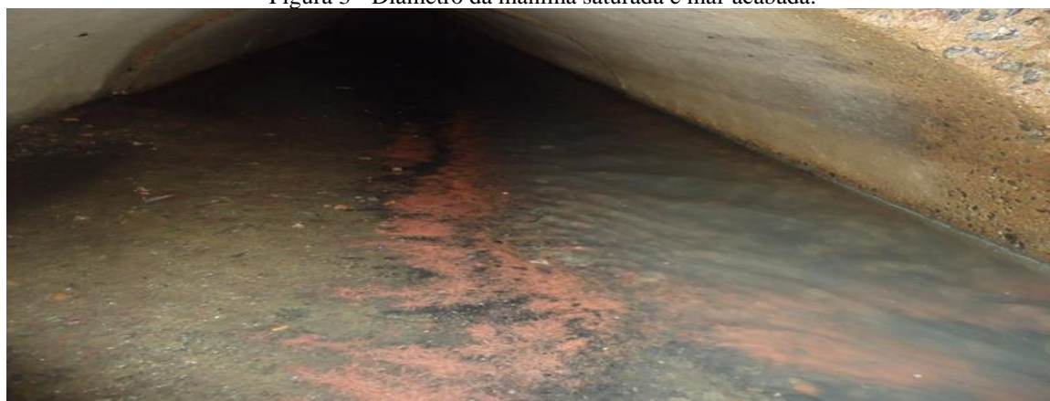
Figura 3 - Diâmetro da manilha saturada e mal-acabada.
