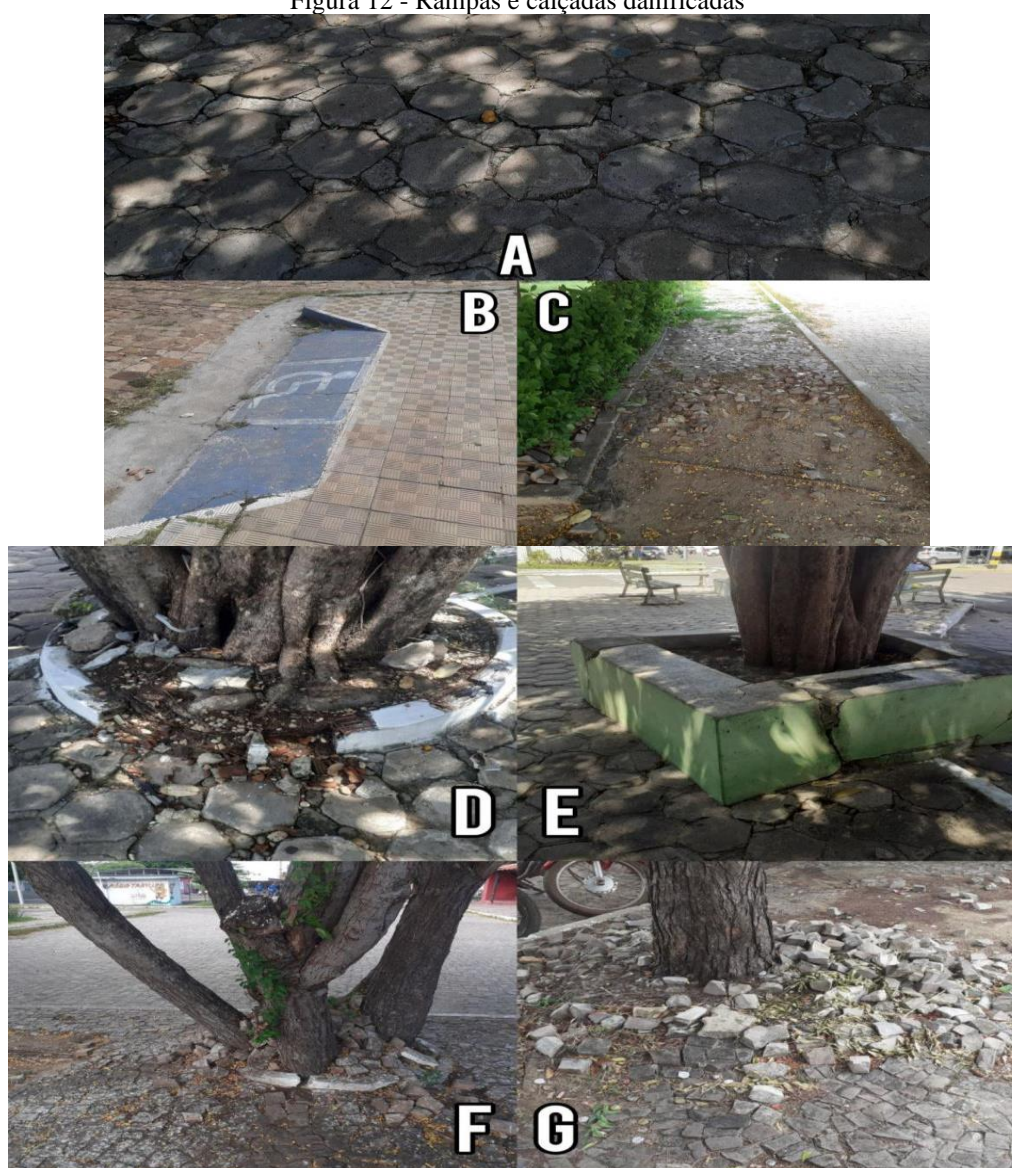
Figura 12 - Rampas e calçadas danificadas
