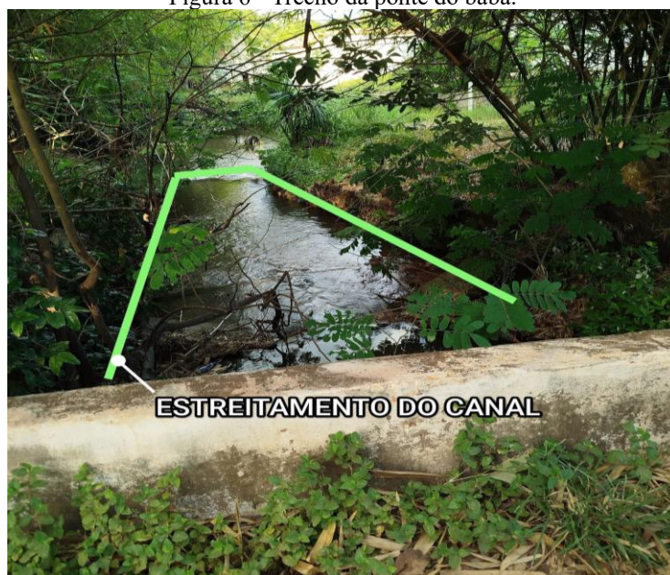
Figura 6 - Trecho da ponte do babá.
