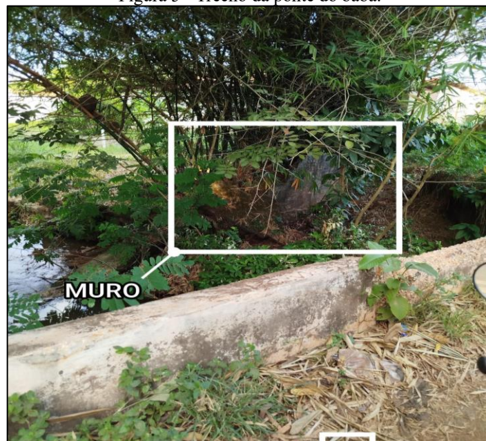
Figura 5 - Trecho da ponte do babá.
