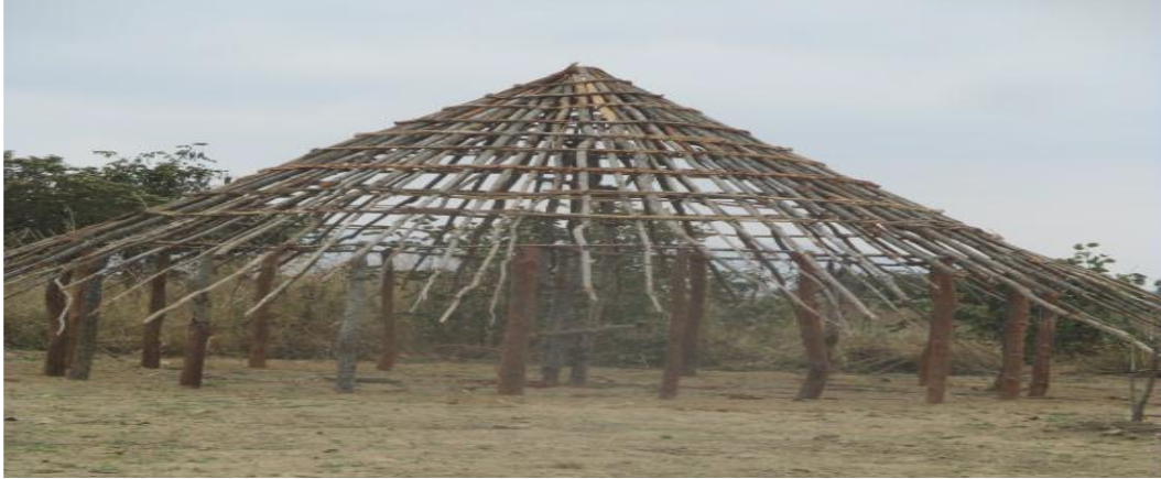
Imagem C4: Casa redonda (palhota) em construção.
